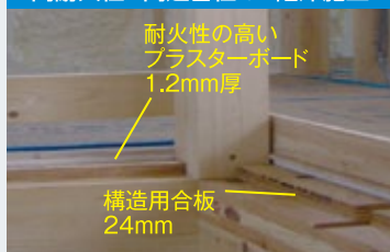
高耐火性&高遮音性の2階床施工
